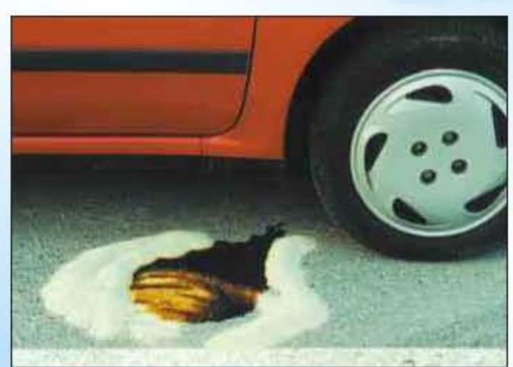
Mantenimiento de carreteras
